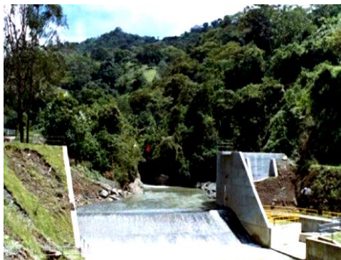
Proyecto Hidroeléctrico Río Piedras (1999)
