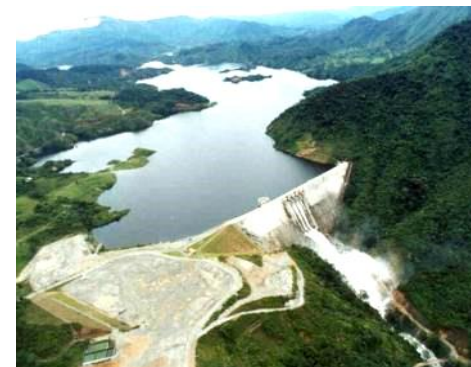
Proyecto Hidroeléctrico Porce II (1988 – 2001)
