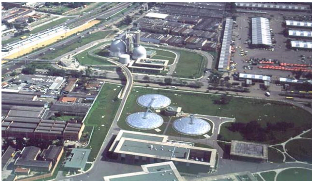
PTAR San Fernando
